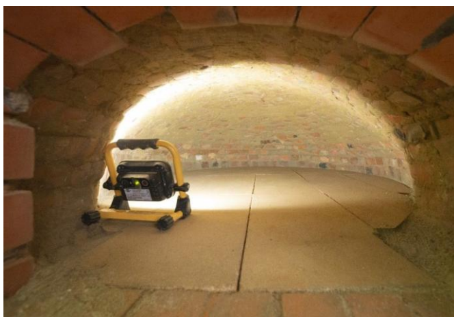
3. 01/06/2024 : vue sur l'intérieur du four et ses pierres réfractaires
